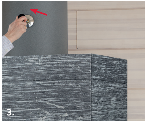
Aprire la valvola della canna fumaria (se installata).
