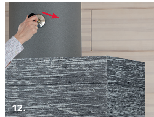
Chiudere la valvola della canna fumaria (se installata).
